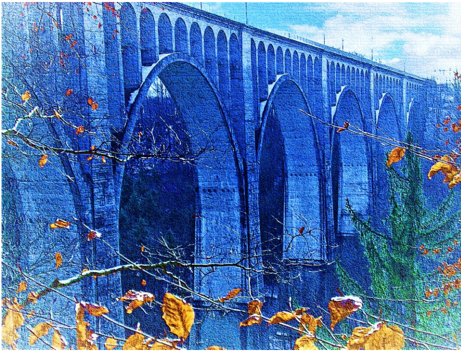
Pont de Grandfey – jete le pont entre la Suisse romande et alémanique
